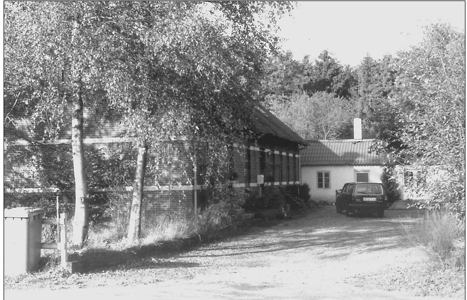
Julianehede gamle skole, Firhusevej
