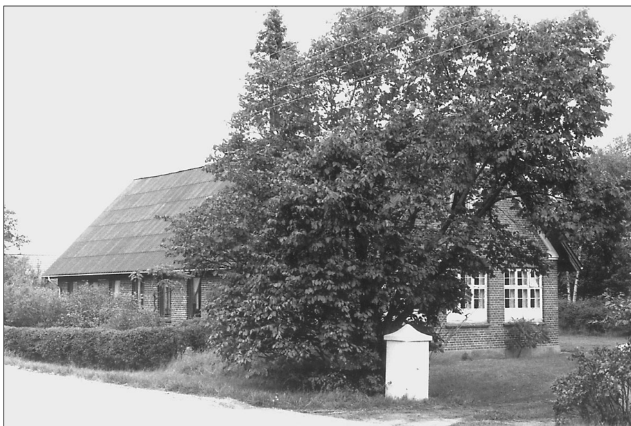
Hestlund gamle skole, Nedre Hestlundvej 31
