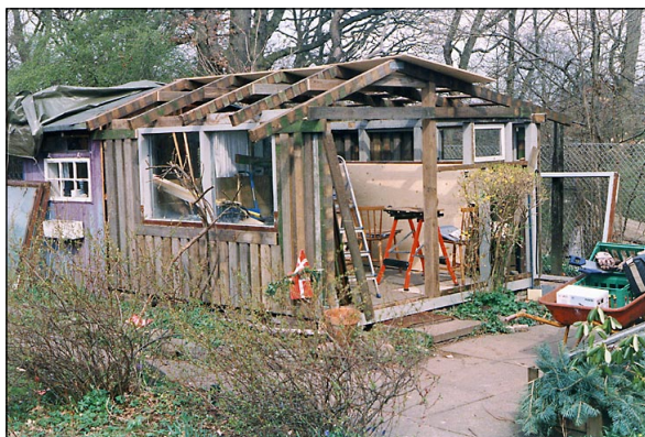
Renovering af et af de ældste huse.
